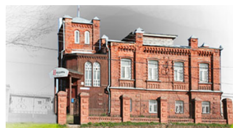
Здание, в котором находится мастерская «Иордань» в пгт. Красное-на-Волге
